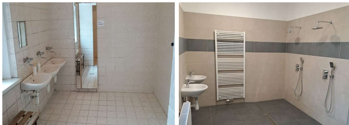
Rekonstrukce sociálního zařízení – před a po
